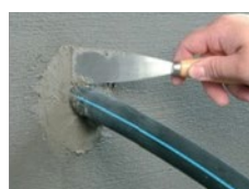
Verspachteln mit Schnellzement
