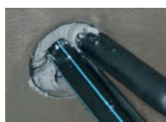
Füllen des Ringspalts
