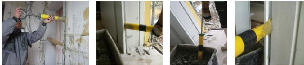
**für Zargen • Fugen • Hohlraumverfüllung mit Mörtel, Suspensionen und Putze bis 4mm Korn**
