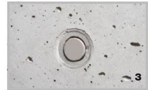
Bündiger Verschluss bei Mauerstärken mit Dichtlippe.
