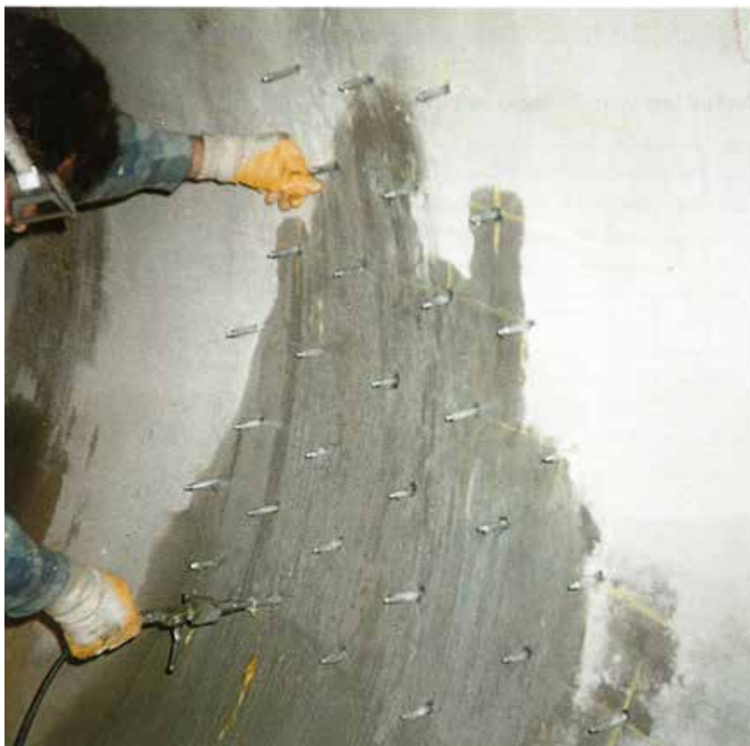
▲ Rasterinjektion mit Bohrpackern
