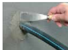
Verspachteln mit Schnellzement
