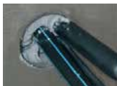
Füllen des Ringspalts
