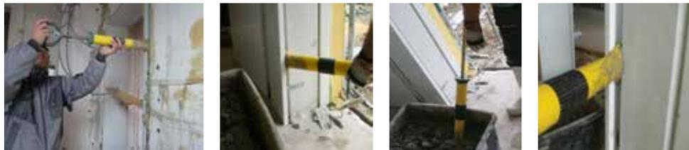
**für Zargen • Fugen • Hohlraumverfüllung mit Mörtel, Suspensionen und Putze bis 4mm Korn**
